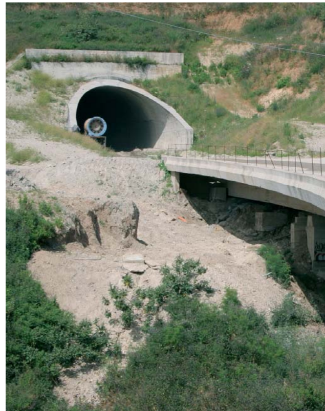
L'imbocco della galleria sul versante Annunziata
