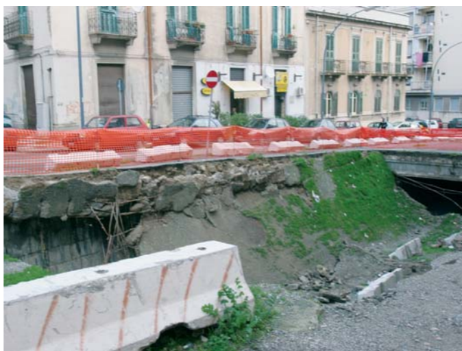
La parte di copertura del torrente Trapani interessata al cedimento strutturale
